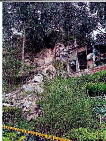
Fotografía 4. Macizo Rocoso Inspeccionado
