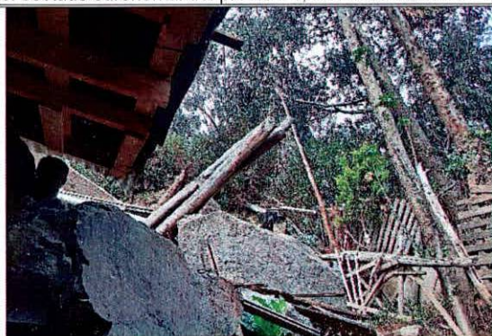
Fotografías 11 y 12. Caída y depósito de rocas sobre el costado norte de la vivienda P1-A
