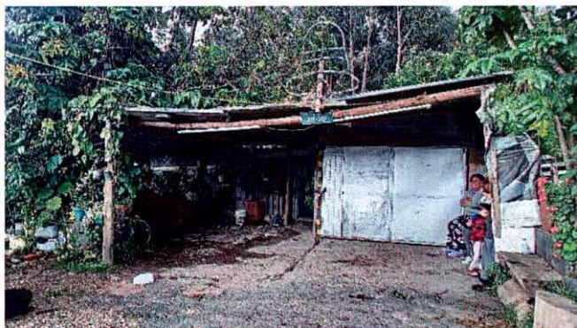
Fotografía 9. Vista de la vivienda ubicada en la franja de viviendas del costado suroriental del predio P1, identificada como P1-A
