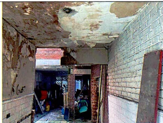
Fotografía 2. Sectores inspeccionados al interior del predio, edificación deshabitada.
