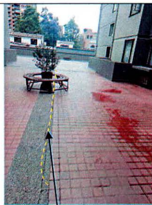
Fotografía 13. Condiciones generales de la plazoleta al interior del inmueble evaluado.
