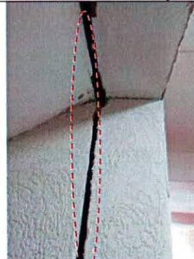
Fotografía 5. Junta de dilatación de la estructura de la Torre A, primer nivel y acceso a sótano.
