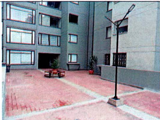
Fotografía 14. Condiciones generales de la plazoleta al interior del inmueble evaluado.
