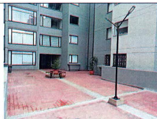
Fotografía 3. Interior del Edificio Pijao Norte P.H
