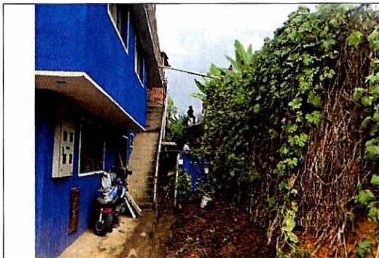
Fotografía 1. Sector de la Calle 156 No 87B - 08, en el Barrio Tuna Alta Sector Bella Vista, en la Localidad de Suba.
