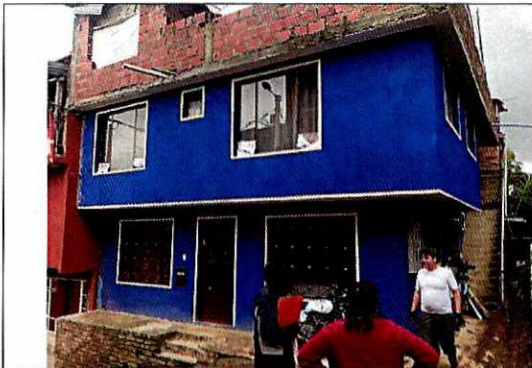
Fotografía 7. Vista de la fachada de la vivienda en la Calle 156 No 87B - 08, en el Barrio Tuna Alta Sector Bella Vista.
