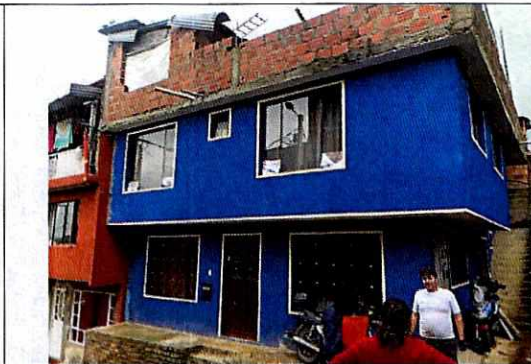
Fotografía 2. Sector de la Calle 156 No 87B - 08, en el Barrio Tuna Alta Sector Bella Vista, en la Localidad de Suba.
