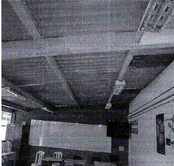
Foto 11. Elementos de cubierta sin daño evidente.
