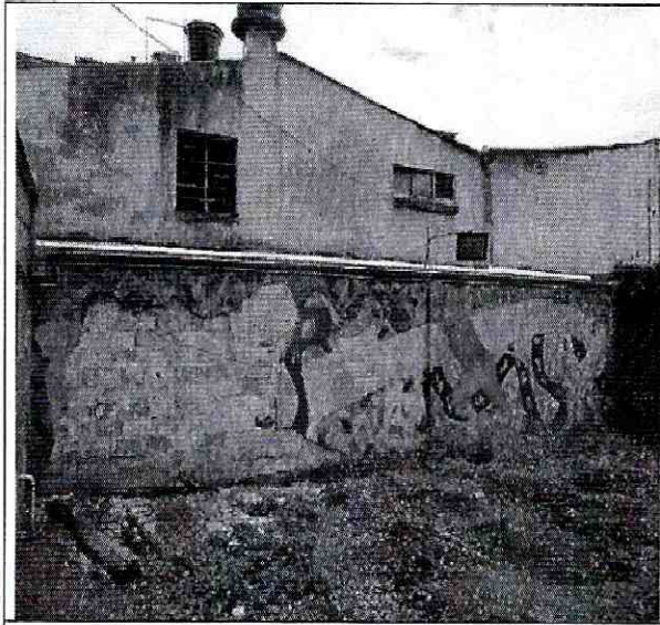
Foto 13. Muro de lindero, tramo suroriental.
