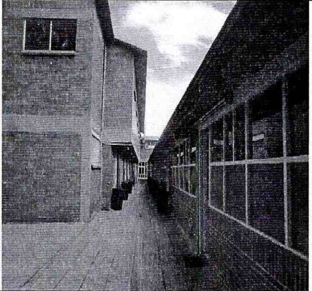
Foto 2. Fachada de la edificación del costado suroriental.
