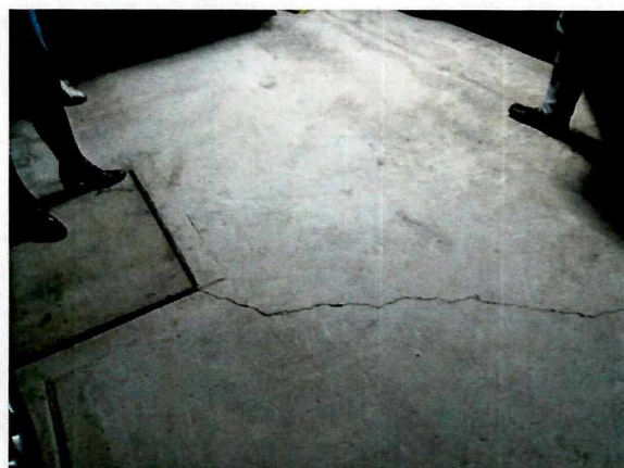
Fotografías 8 y 9. Fisuras en el contrapiso de los parqueaderos de primer piso
