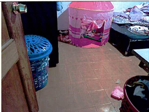
Fotografía 5. Tipología de estado general de muros y piso al costado occidental del predio P1.
