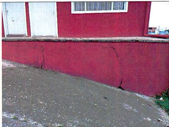
Fotografía 3. Fisuras de tendencia vertical en muro de andén de acceso.
