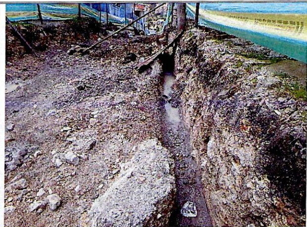
Fotografía No. 5. Vista de las excavaciones frente a las viviendas evaluadas.
