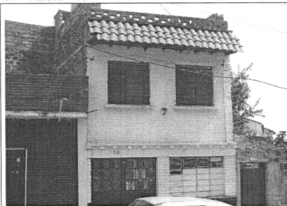
Foto 1. Fachada de la edificación
