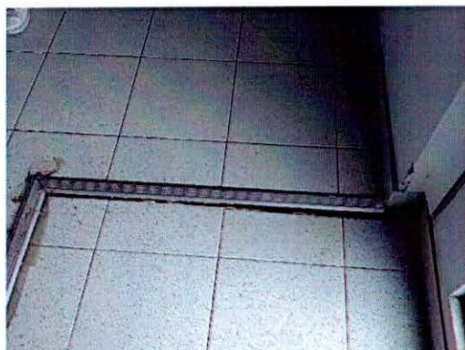
Fotografías 33 y 34. Dilataciones en el salón social (estructura 2) predio P1.
