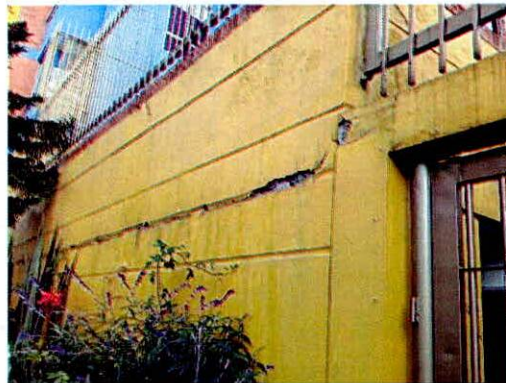
Fotografías 22 y 23. Daños identificados en el muro localizado al costado noroccidental del predio P2. (Fotografía tomada del diagnóstico técnico DI-18707)
