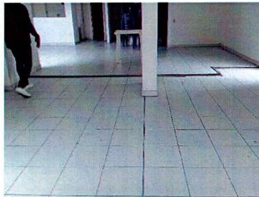
Fotografías 33 y 34. Dilataciones en el salón social (estructura 2) predio P1.
