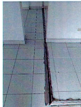
Fotografías 33 y 34. Dilataciones en el salón social (estructura 2) predio P1.
