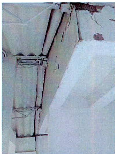
Fotografías 37 y 38. Manchas de humedad y dilataciones en el salón social (estructura 2) predio P1.
