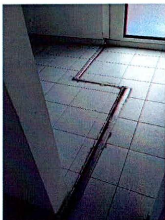
Fotografías 33 y 34. Dilataciones en el salón social (estructura 2) predio P1.
