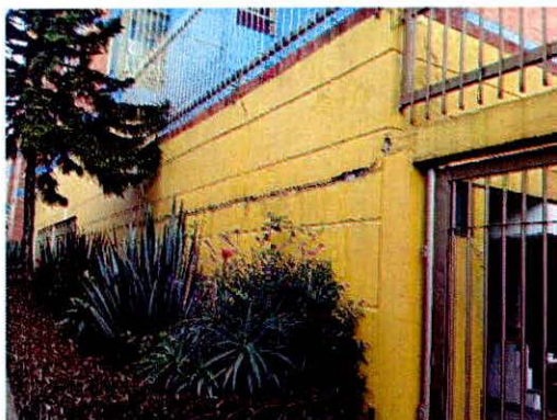
Fotografías 22 y 23. Daños identificados en el muro localizado al costado noroccidental del predio P2. (Fotografía tomada del diagnóstico técnico DI-18707)
