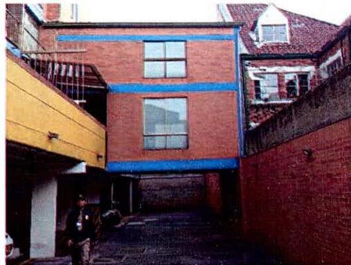
Fotografía 21. Estructura 2 localizadas en el predio P2.
