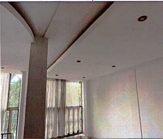
Foto 7. Nivel 2 y 3 de P2 sin aparentes daños
