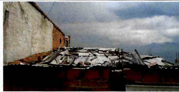
Fotografía 2. Vista del estado de la cubierta que conforma el predio evaluado.
