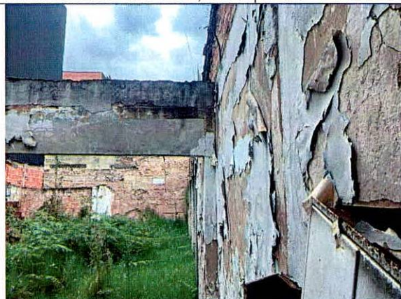
Fotografía 6. Vista al interior del predio P2, lote vacío.
