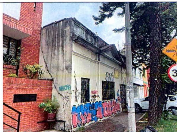
Fotografía 2. Grieta de tendencia diagonal sobre muro de fachada de P2.
