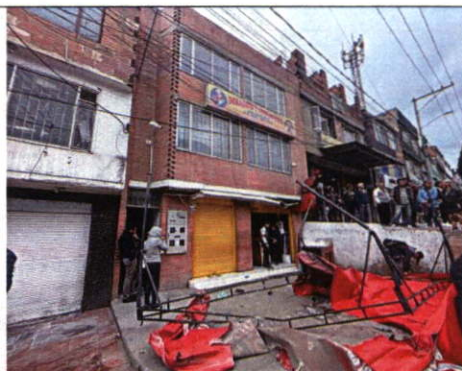
Fotografía 2. Fachada predio Tv 50 # 76 - 16
