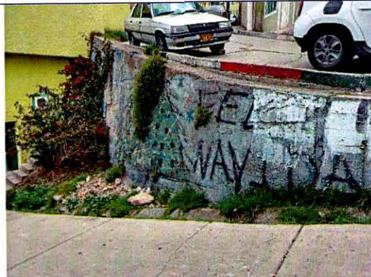
Fotografía 2. Muro de contención ubicado en la KR 2C a la altura de la DG 163 BIS.
