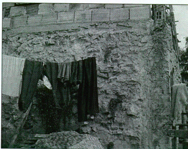
Foto No.5. Vista del muro de contención del predio vecino del costado norte.
