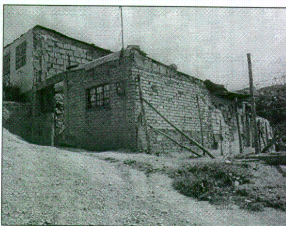
Foto No.1. Se observa la fachada del costado sur de la vivienda ubicada en la Carrera 4 Bis A No. 52B - 40 sur.
