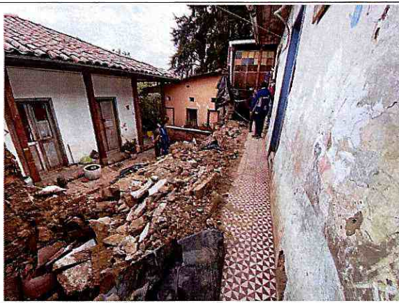
Fotografía 2. Vista del sector donde se presentó el colapso del muro medianero de los predios evaluados.
