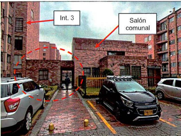
Fotografía 6. Estructura de un nivel en el costado occidental del salón comunal (19/04/2023)
