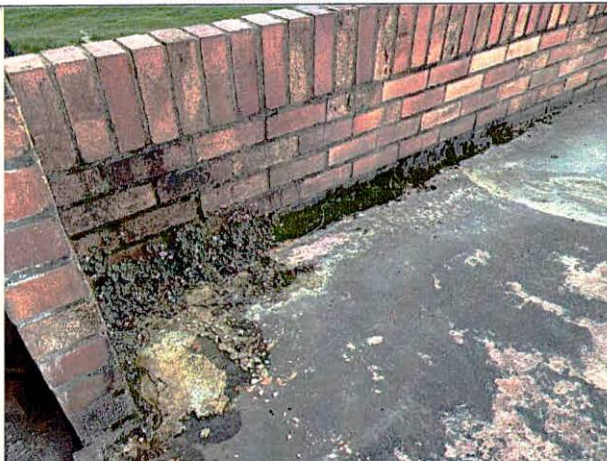
Fotografía 15. Presencia de vegetación en las juntas de la placa de cubierta del salón comunal
