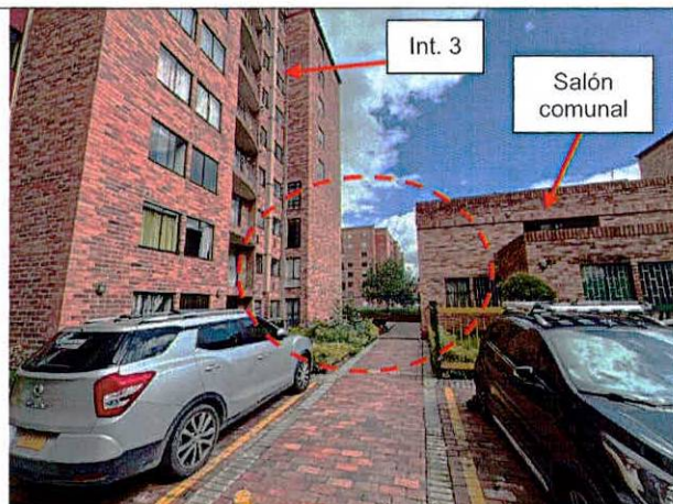
Fotografía 7 . Demolición de la estructura de un nivel en el costado occidental del salón comunal
