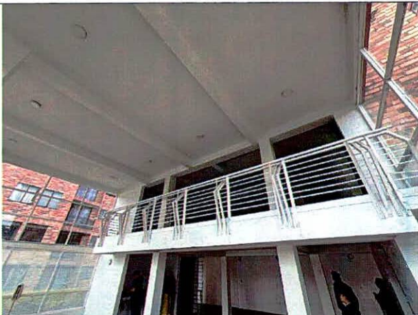
Fotografía 4. Costado norte a doble altura en el salón comunal
