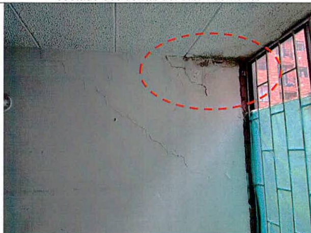
Fotografías 9 y 10. Humedad en muros de mampostería reforzada del antiguo apartamento modelo
