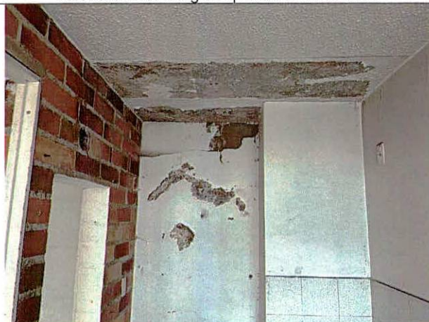
Fotografías 9 y 10. Humedad en muros de mampostería reforzada del antiguo apartamento modelo
