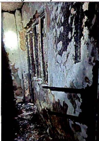
Fotografías 5 y 6. Deformación en la ventanearía al interior del apartamento del primer nivel.
