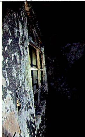
Fotografías 5 y 6. Deformación en la ventanearía al interior del apartamento del primer nivel.
