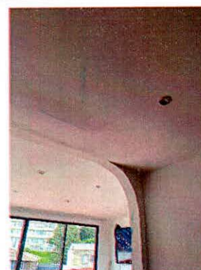
Fotografías 12 y 13. Manchas de humedad al interior del apartamento 602 predio evaluado.
