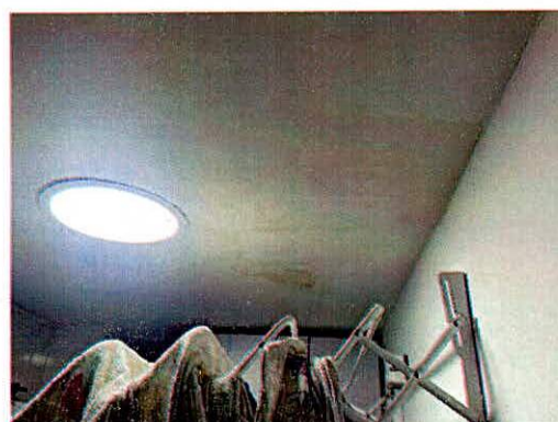
Fotografías 12 y 13. Manchas de humedad al interior del apartamento 602 predio evaluado.
