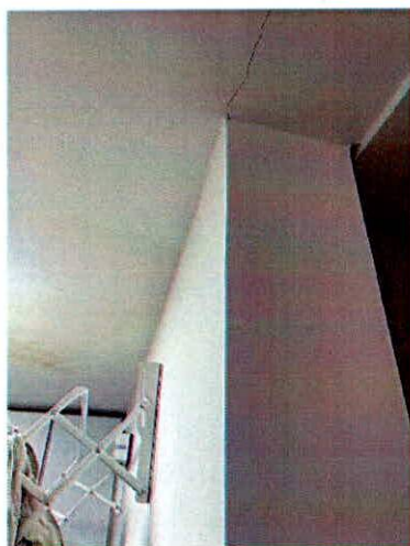
Fotografías 14 y 15. Fisuras al interior del apartamento 602 predio evaluado.
