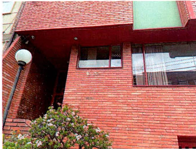
Fotografías 1 y 2. Fachada predio evaluado.
