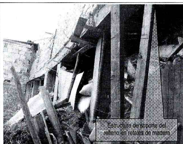
Fotos 9 y 10. Se evidencia las adecuaciones realizadas en el predio de la Carrera 15 Bis B No. 32-31 Sur, en cuanto al reforzamiento y nivelación del terreno para el emplazamiento de la vivienda del predio en concreto, mediante la implementación de columnas y vigas en concreto reforzado; dichas adecuaciones presentan deficiencias constructivas debido a que el relleno se encuentra soportado en retales de madera.
