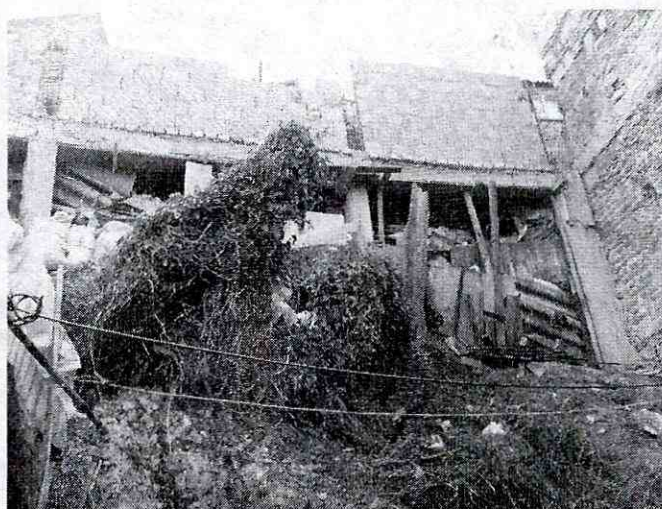
Foto 6. Se evidencia que el predio de la Carrera 15 Bis B No. 32-31 Sur, se encuentra adelantando obras hacia el costado Nor-Occidental del predio, para la adecuación del terreno, mediante la implementación de columnas y vigas en concreto reforzado. Tomada el día 12 de Septiembre de 2011.
