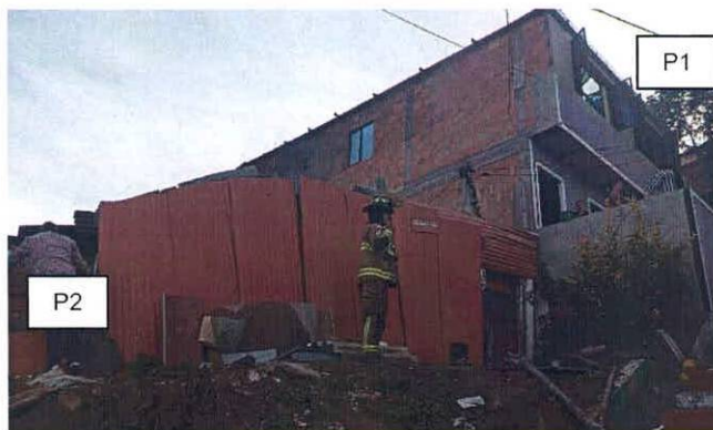
Fotografía 3. Vista de la fachada de los predios P1 y P2.
