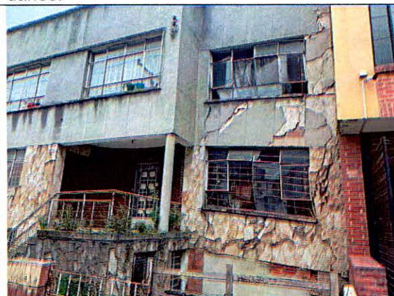
Fotografía 8. Vista desde el exterior de P2, costado norte de la vivienda.
