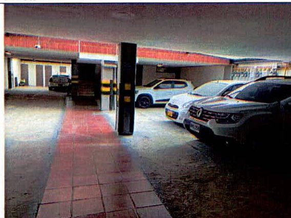
Fotografía 6. Elementos que conforman la estructura del primer nivel, sin evidencia de daños.
