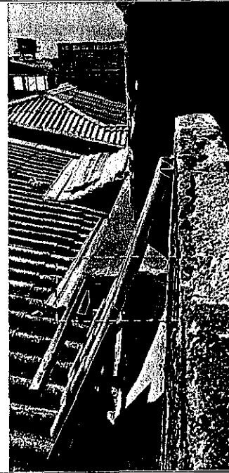
Fotografía 6. Perfiles metálicos instalados al parecer para reforzar la placa donde se instalaron los tanques para almacenamiento de agua.
