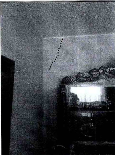
Fotografía 3. Fisuras identificadas en muros del costado norte de la vivienda ubicada en el predio de la Carrera 68 D No. 95 – 26, en el Sector Catastral Julio Flórez de la Localidad Suba.
