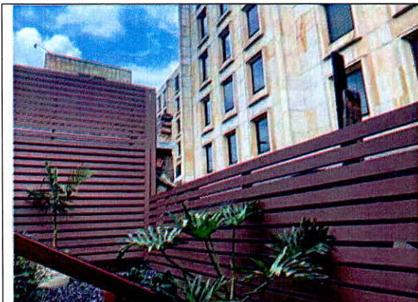
Fotografía 3. Instalación de cerramiento en perfiles metálicos sin evidencia de daños.
