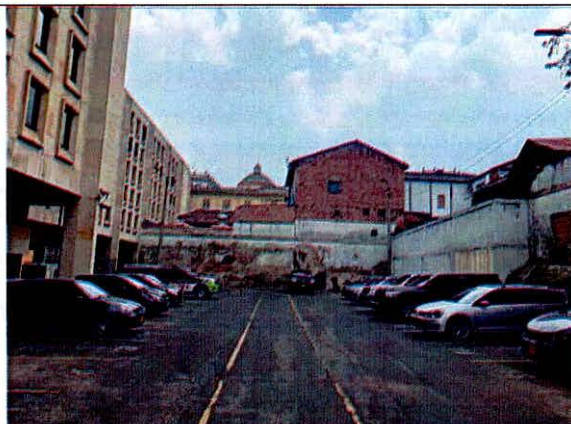
Fotografía 4. Vista al interior de P2: KR 7 # 8 – 30, zona de parqueadero y edificio de seis niveles.
