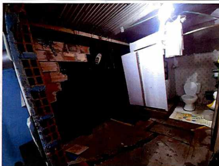
Fotos 1 y 2. Vista del colapso parcial del muro de cerramiento de la vivienda evaluada, junto con la fractura y pérdida de horizontalidad de la placa.
