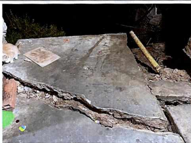
Fotos 5, 6, 7 y 8. Daños adicionales identificados al interior de la vivienda evaluada asociados principalmente con agrietamientos sobre muros y pisos y daños en las redes de aguas servidas.
