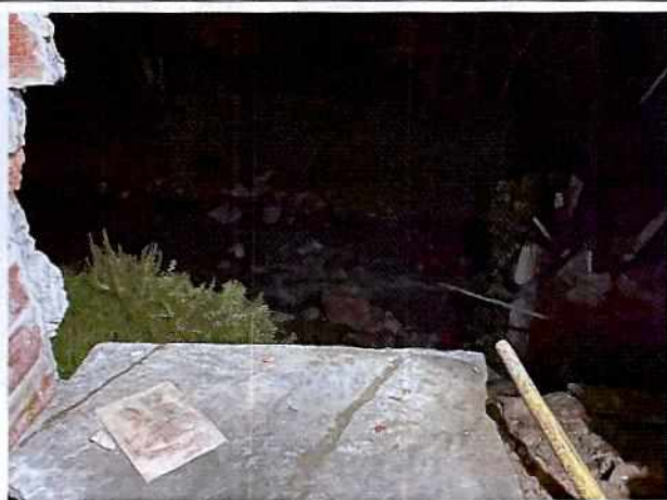
Fotos 5, 6, 7 y 8. Daños adicionales identificados al interior de la vivienda evaluada asociados principalmente con agrietamientos sobre muros y pisos y daños en las redes de aguas servidas.
