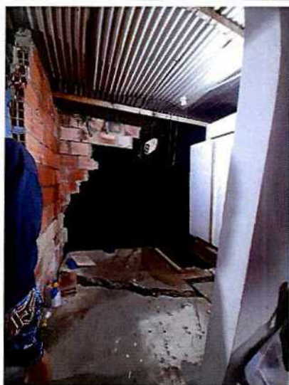
Fotos 1 y 2. Vista del colapso parcial del muro de cerramiento de la vivienda evaluada, junto con la fractura y pérdida de horizontalidad de la placa.
