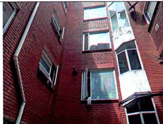
Fotografía 4. Vista al interior de la edificación emplazada en el predio de la AK 50 No. 16 - 16 Sur.
