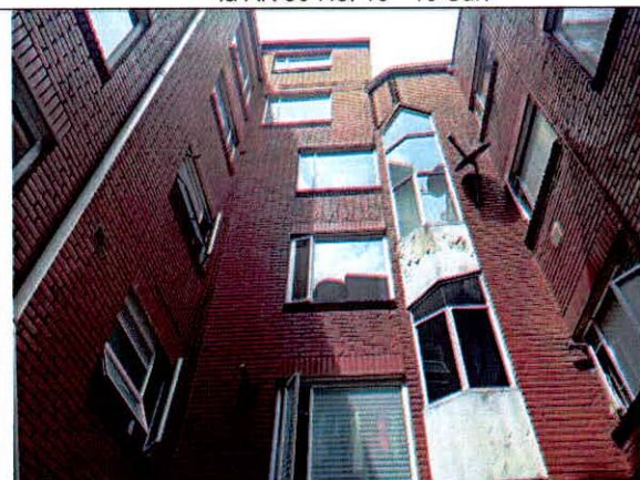
Fotografía 3. Vista al interior de la edificación emplazada en el predio de la AK 50 No. 16 - 16 Sur.
