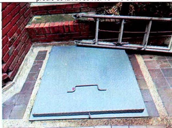
Fotografía 5. Ubicación del tanque de agua al interior de la edificación emplazada en el predio de la AK 50 No. 16 - 16 Sur.
