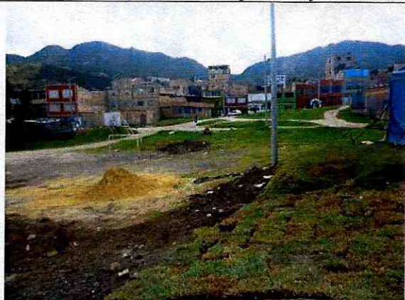
Fotografías 8 y 9. En el predio se evidencia la modificación de la topografía del terreno, mediante actividades de corte y disposición de rellenos.
