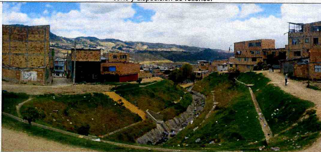
Fotografía 10. En el límite norte del predio se localiza el caño Chuniza, en el cual se aprecian obras de canalización, revegetalización y drenaje, las cuales contribuyen al control de la erosión y estabilización de los taludes adyacentes.
