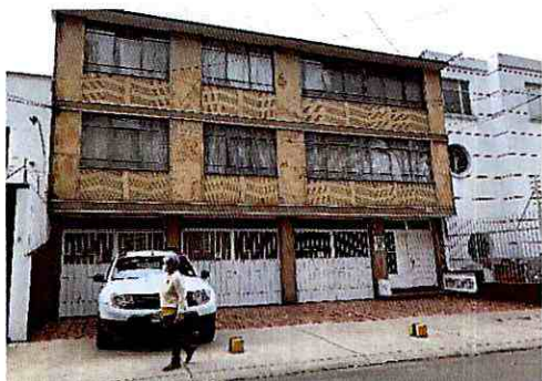
Fotografía 1. Fachada de la edificación del predio de la Carrera 21 No 57 – 16 (P1), en el Sector Catastral San Luis
