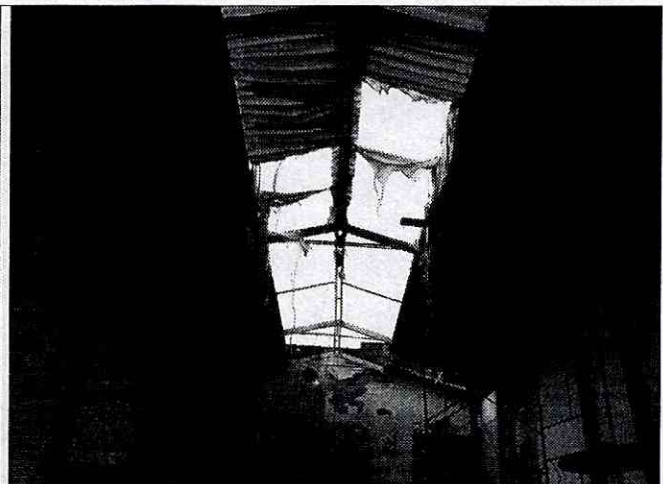
Foto 2. Detalle al interior del predio donde se evidencia las afectaciones sufridas por la conflagración.
