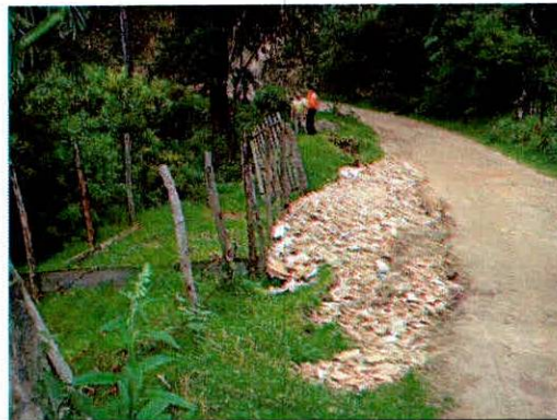
Fotografía 3. Se observa la corona del proceso de remoción en masa identificado. (Fotografía tomada del diagnóstico técnico DI-4109 de 2009)
