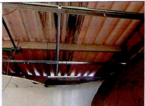
Fotografía 5. Estructura metálica que soporta el cielo raso, sin afectaciones.
