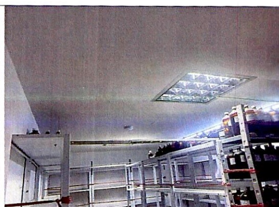
Fotografía 2. Vista al interior de la edificación. Fábrica de productos químicos.
