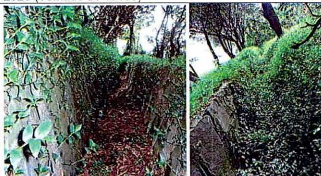
Fotografía 10. Estado general de la estructura del canal trapezoidal. (Tomado del DI-15103 de noviembre de 2020).
