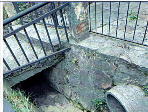
Fotografía 9. Acceso peatonal CL 121 y estructura de canal trapezoidal, condiciones evidenciadas el 02 de mayo de 2024.
