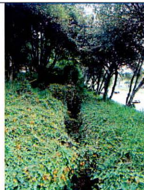
Fotografía 13. Estado general de la estructura del canal trapezoidal. (Condiciones evidenciadas el 02 de mayo de 2024).
