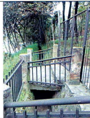
Fotografía 7. Acceso peatonal CL 121 costado occidental del talud evaluado, condiciones evidenciadas el 02 de mayo de 2024.
