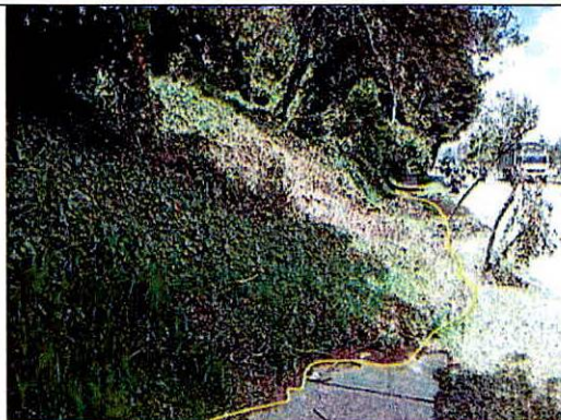
Fotografía 6. Acceso peatonal CL 121 costado occidental del talud evaluado
