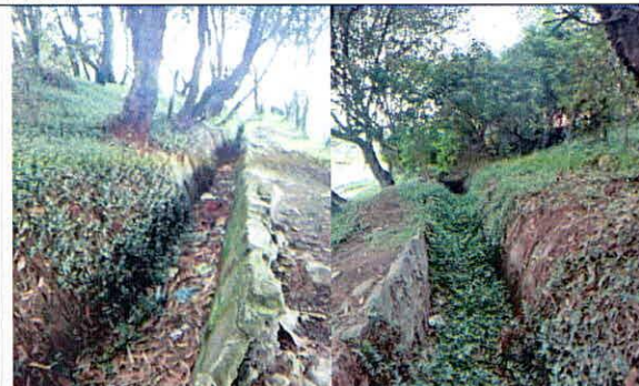
Fotografía 11. Estado general de la estructura del canal trapezoidal. (Condiciones evidenciadas el 02 de mayo de 2024).
