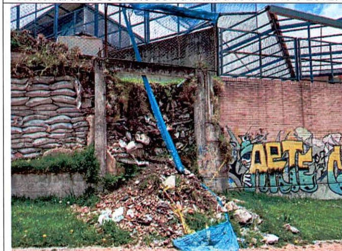
Fotografía 5. Material depositado sobre zona verde de sendero peatonal.
