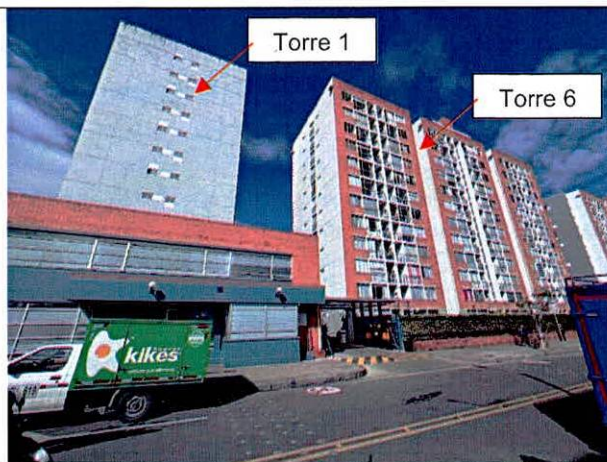
Fotografía 2. Fachada del predio de la Calle 151 No. 109A-25
