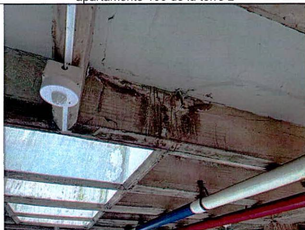
Fotografías 9 y 10. Humedad, manchas de eflorescencia y filtraciones de agua en la placa superior de las plataformas de parqueaderos
