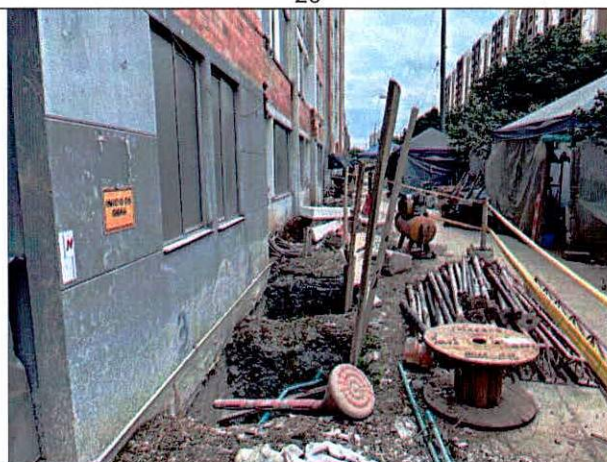
Fotografía 4. Reforzamiento de la cimentación en las torres 1, 2 y 3
