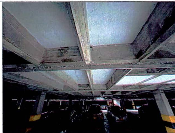
Fotografías 9 y 10. Humedad, manchas de eflorescencia y filtraciones de agua en la placa superior de las plataformas de parqueaderos
