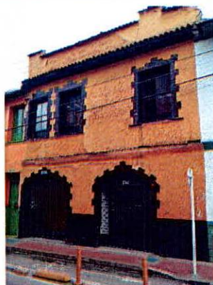
Fotografía 20. Fachada predio P3 y zona de ingreso para predio P3 y P5.
