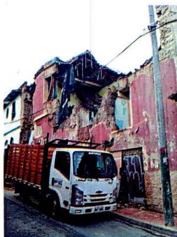
Fotografía 1. Fachada predio P1.
