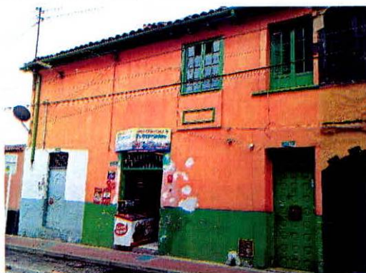
Fotografía 21. Fachada predio P4.
