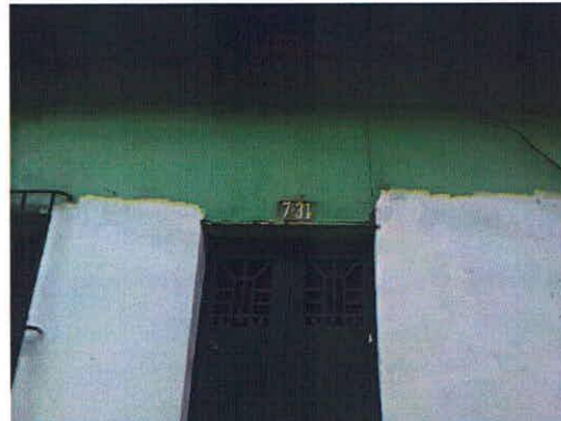
Fotografías 12 y 13. Fachada predio P2
