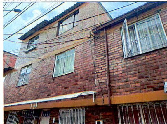
Fotografía 7. Vista de las fachas de las viviendas. Sin evidencia de daños.
