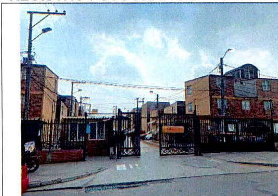
Fotografía 1. Conjunto Residencial La Estancia del Camino Salazar II Etapas I.II.III
