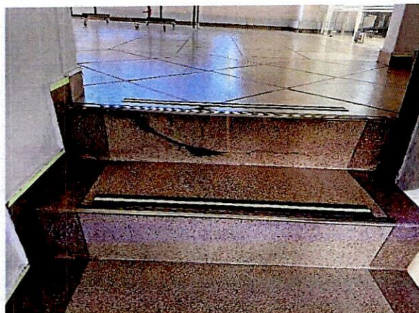
Fotografías 3 y 4. Daños identificados en acabados de pisos y escaleras al interior del predio evaluado.
