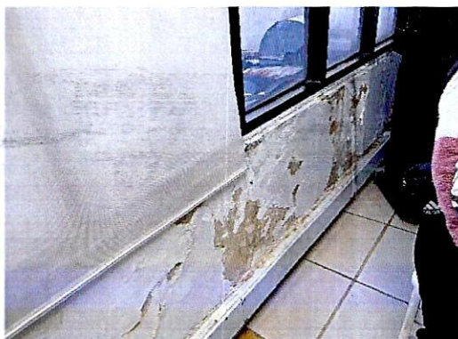
Fotografías 9 y 10. Manchas de humedad en muros de antepecho y perimetrales al interior del predio evaluado.
