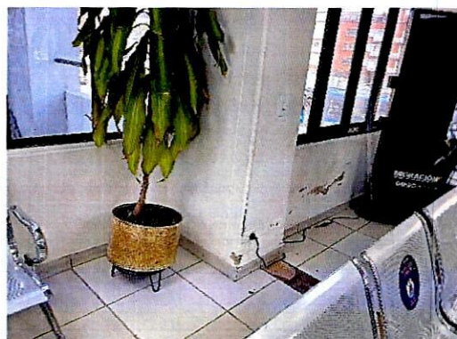
Fotografías 9 y 10. Manchas de humedad en muros de antepecho y perimetrales al interior del predio evaluado.
