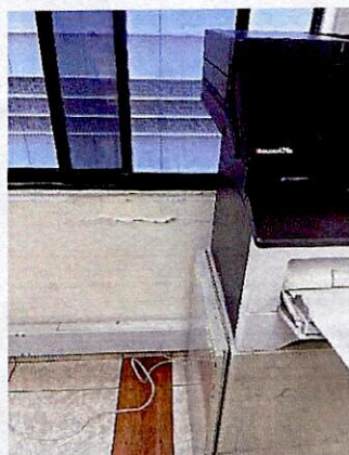
Fotografías 7 y 8. Manchas de humedad en muros de antepecho y perimetrales al interior del predio evaluado.
