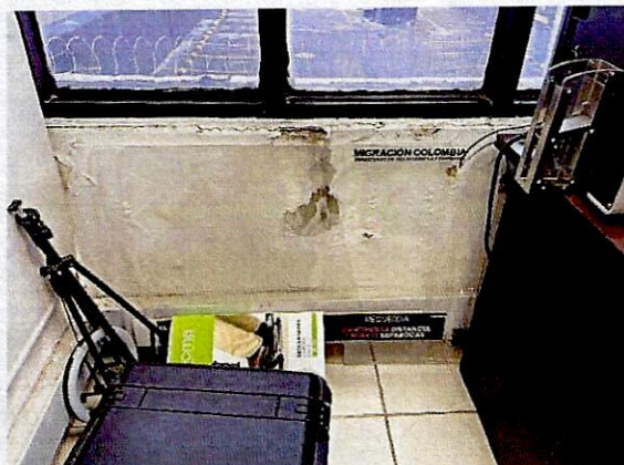
Fotografías 7 y 8. Manchas de humedad en muros de antepecho y perimetrales al interior del predio evaluado.
