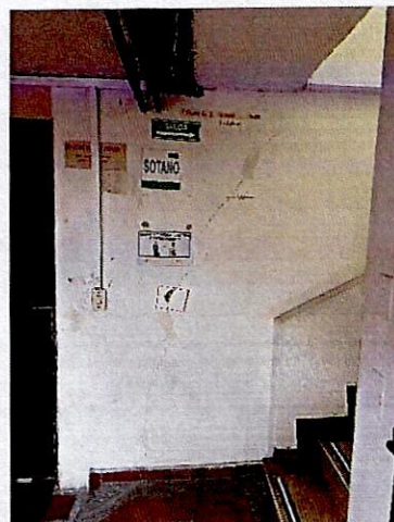
Fotografías 17 y 18. Grietas y manchas de humedad localizadas en muros divisorios primer nivel del predio evaluado.
