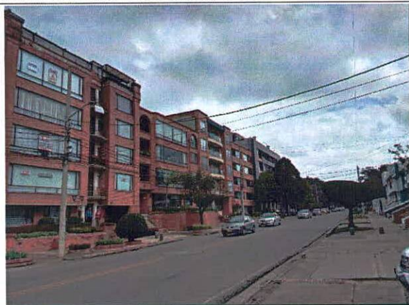
Fotografía 1. Vista general del sector de la KR 13 119 39.
