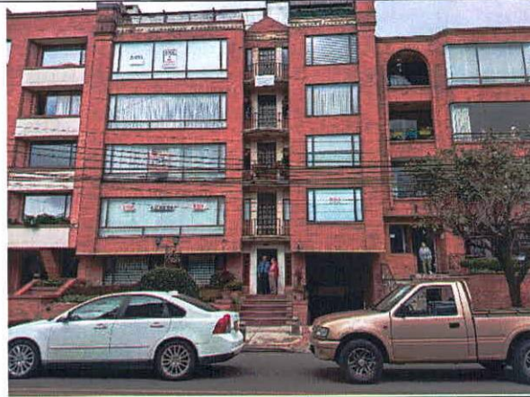
Fotografía 2. Edificio de la KR 13 119 39.
