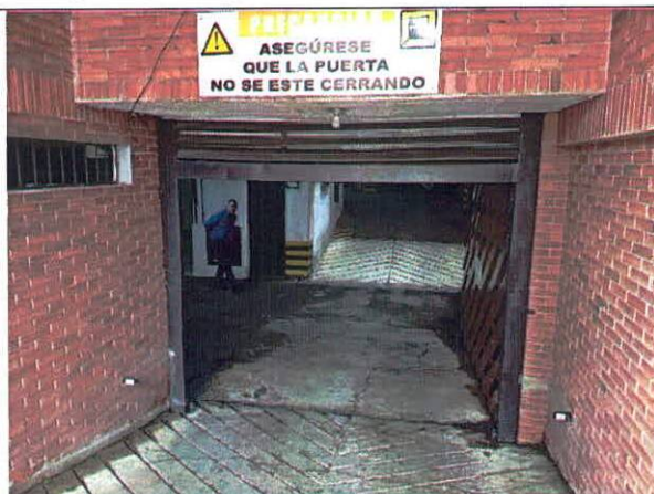
Fotografía 3. Zona de ingreso a parqueaderos.
