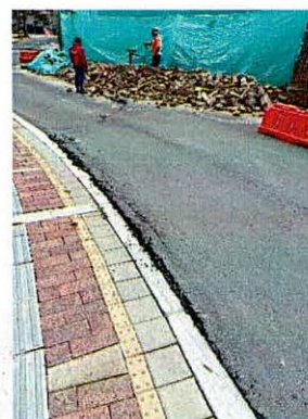
Fotografías 16 y 17. Levantamiento de la estructura de pavimento vía vehicular evaluada (fotografía tomada el 06 de mayo de 2024)
