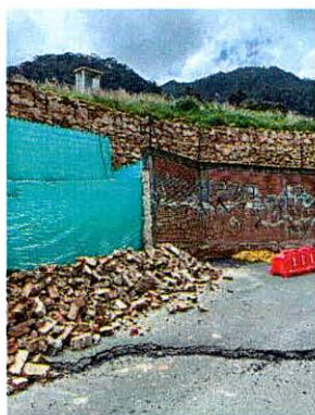
Fotografías 14 y 15. Levantamiento de la estructura de pavimento vía vehicular evaluada (fotografía tomada el 06 de mayo de 2024)
