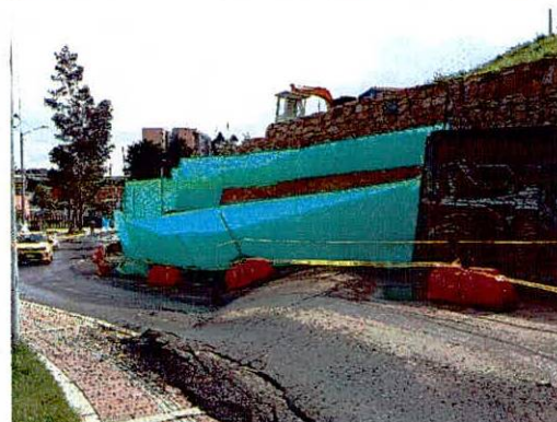
Fotografías 40 y 41. Muro de cerramiento zona donde se presenta colapso de mampuestos (fotografía tomada el 14 de mayo de 2024)
