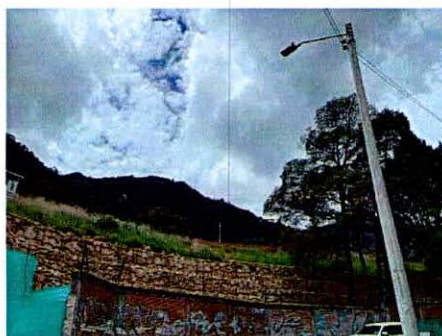
Fotografía 21. Gaviones localizados parte posterior muro de cerramiento evaluado (fotografía tomada el 06 de mayo de 2024)
