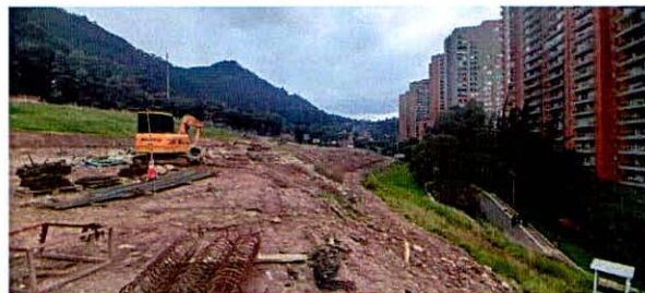
Fotografías 19 y 20. Terraceo terreno localizado en el predio P1 (fotografía tomada el 06 de mayo de 2024)
