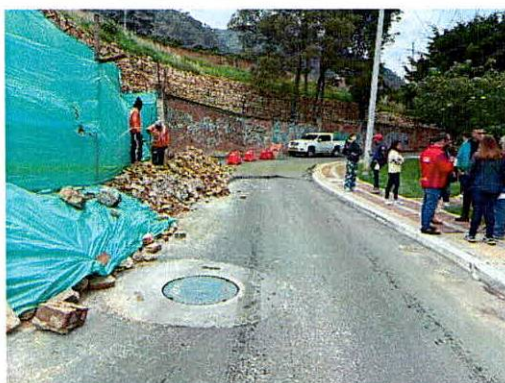
Fotografía 18. Levantamiento de la estructura de pavimento vía vehicular evaluada (fotografía tomada el 06 de mayo de 2024)
