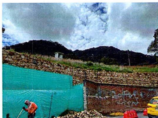
Fotografías 10 y 11. Muro de cerramiento zona donde se presenta colapso de mampuestos (fotografía tomada el 06 de mayo de 2024)
