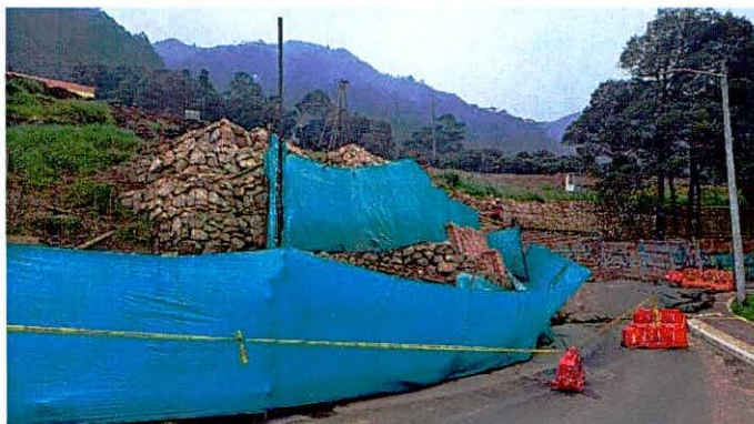
Fotografías 36 y 37. Afectación en las estructuras de gaviones (fotografía tomada el 14 de mayo de 2024)
