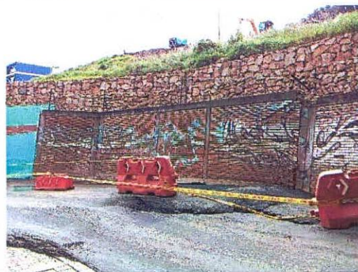
Fotografías 42 y 43. Muro de cerramiento zona donde se presenta colapso de mampuestos (fotografía tomada el 14 de mayo de 2024)
