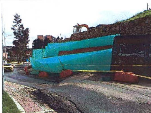
Fotografías 42 y 43. Muro de cerramiento zona donde se presenta colapso de mampuestos (fotografía tomada el 14 de mayo de 2024)
