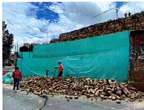
Fotografías 10 y 11. Muro de cerramiento zona donde se presenta colapso de mampuestos (fotografía tomada el 06 de mayo de 2024)
