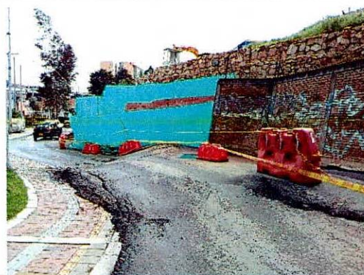
Fotografías 28 y 29. Levantamiento de la estructura de pavimento vía vehicular evaluada (fotografía tomada el 14 de mayo de 2024)
