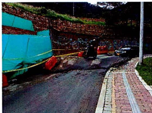
Fotografías 30 y 31. Levantamiento de la estructura de pavimento vía vehicular evaluada (fotografía tomada el 14 de mayo de 2024)
