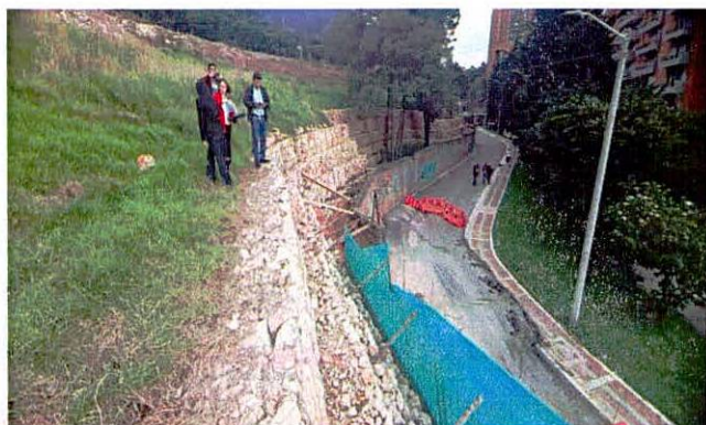
Fotografías 38 y 39. Afectación en las estructuras de gaviones (fotografía tomada el 14 de mayo de 2024)
