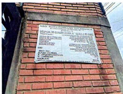
Fotografía 24. Licencia de construcción (fotografía tomada el 06 de mayo de 2024)
