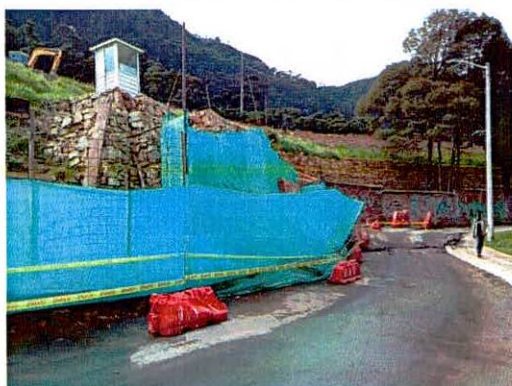
Fotografías 40 y 41. Muro de cerramiento zona donde se presenta colapso de mampuestos (fotografía tomada el 14 de mayo de 2024)
