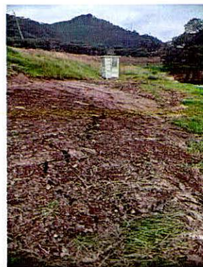
Fotografías 34 y 35. Grieta de tracción zona de ladera predio P1 (fotografía tomada el 14 de mayo de 2024)
