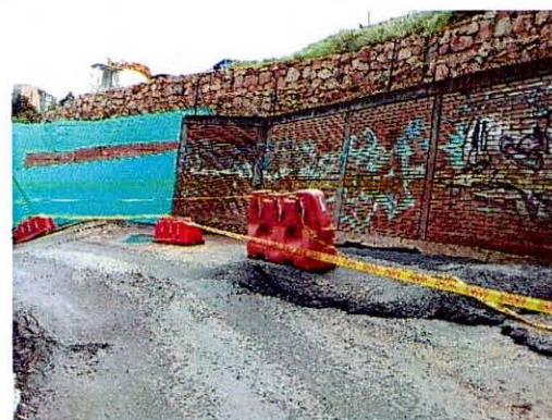
Fotografías 28 y 29. Levantamiento de la estructura de pavimento vía vehicular evaluada (fotografía tomada el 14 de mayo de 2024)
