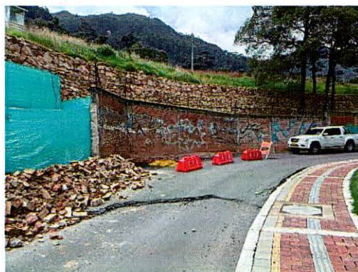
Fotografías 14 y 15. Levantamiento de la estructura de pavimento vía vehicular evaluada (fotografía tomada el 06 de mayo de 2024)
