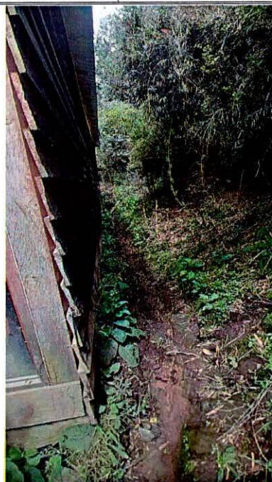
Fotografía 4. Cunetas en suelo natural implementadas alrededor de la cabaña correspondiente a la construcción 1, con coordenadas de localización (E:107350.071 N:102150.309), para drenaje de aguas.
