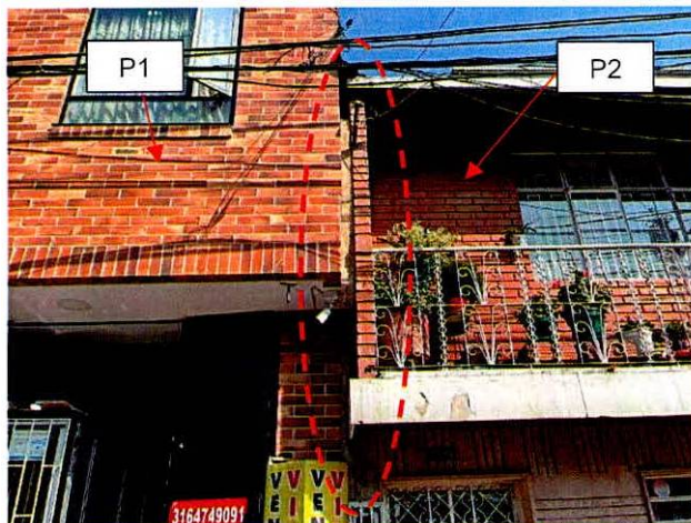
Fotografía 3. Junta de dilatación entre los predios P1 y P2
