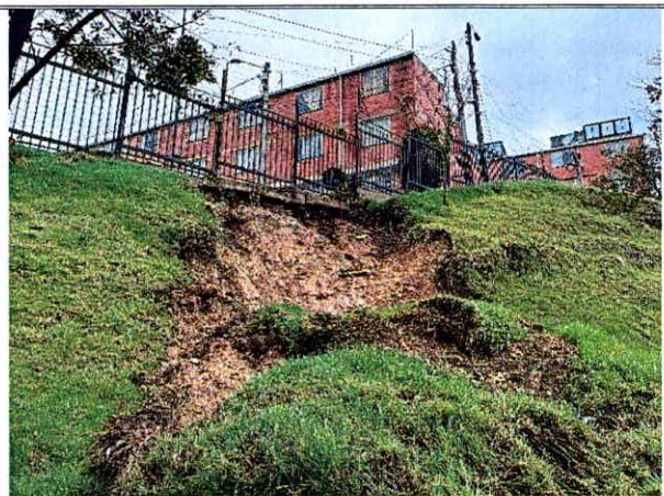
Fotografía No. 4. Vista del movimiento en masa en el talud evaluado.
