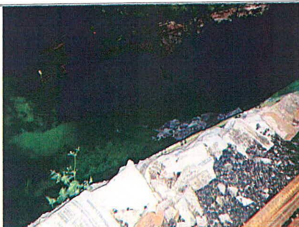
Fotografías 7 y 8. Vista del muro en saco suelo y caída parcial del mismo en el costado norte. (29/05/2024)
