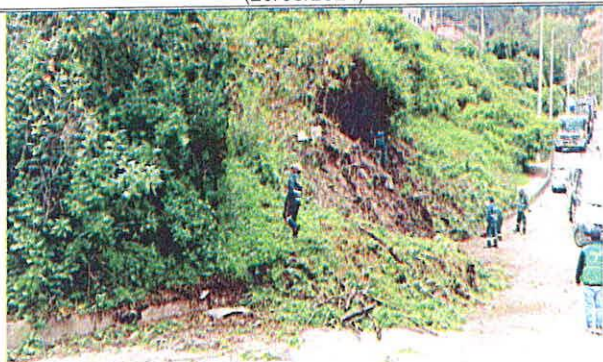
Fotografía 11. Movimiento del material que obstruye la vía de la calle 62 (30/05/2024)
