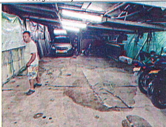
Fotografía 9. Bodega en material de recuperación que tiene como uso el parqueo de vehículos ubicado en la corona del talud. (29/05/2024)
