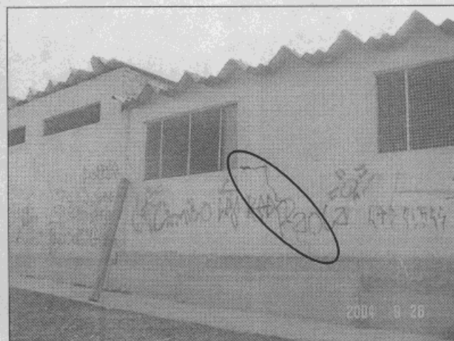
Fotografía 3. Se observa hundimiento en la esquina noroccidental de uno de los salones; lugar de mayor afectación de la estructura del mismo. Fotografía 4. Se observa exteriormente la grieta referida en la fotografía anterior.
