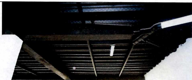
Fotografía 3 y 4. Pandeo en celda de steel deck en parqueadero del primer nivel y detalle de la viga de soporte de dicho panel
