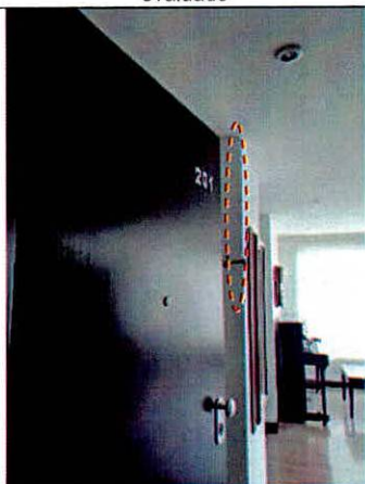
Fotografía 6. Acceso al apartamento 201 de la edificación
