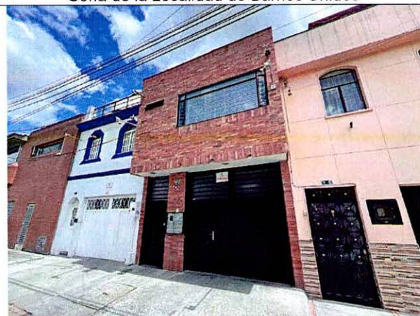
Fotografía 3. Fachada del predio P2
