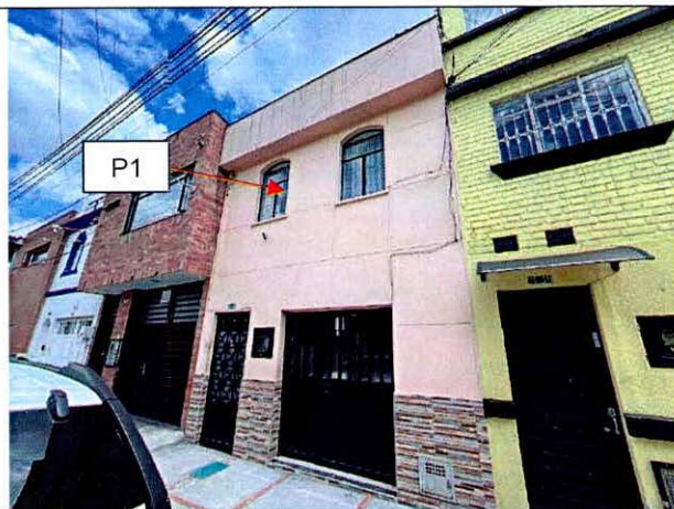
Fotografía 2. Fachada del predio P1
