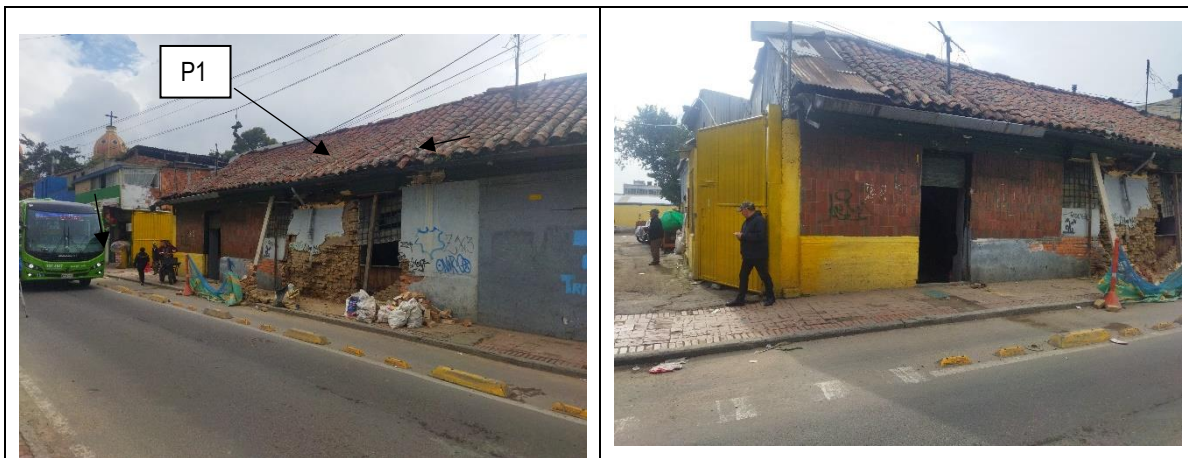
Fotografías 1-2. Fachada del predio P1 (23/05/2023)
